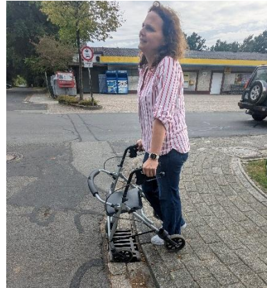
Abbildung 18: Einmündung Möntkeweg (links) und Demonstration der Fahrt eines Rollators über die Absenkung und den Straßenablauf (rechts)
