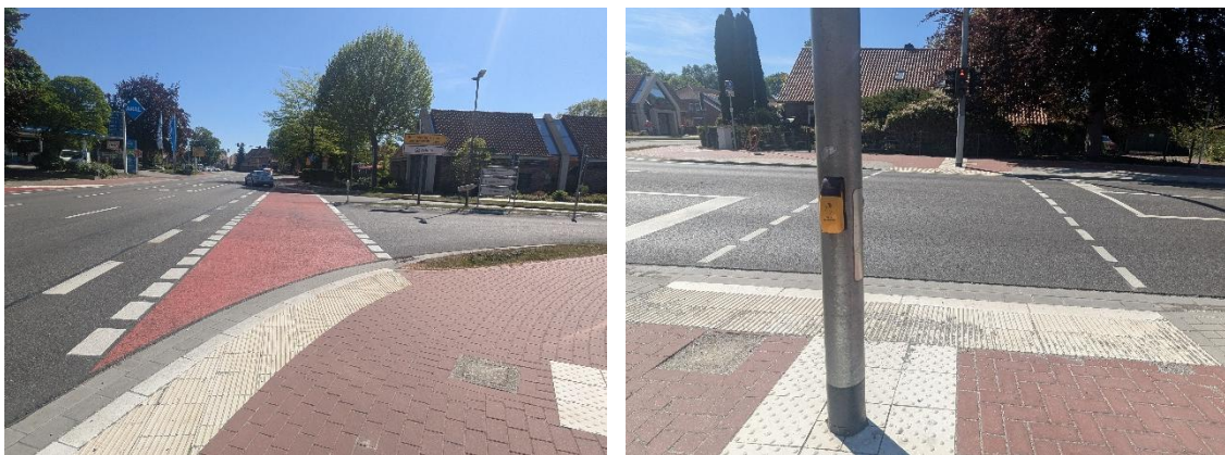
Abbildung 23: Furt in der Einmündung der Stikelkamper Straße (links) und Fußverkehrsampel über die Auricher Straße (rechts)
