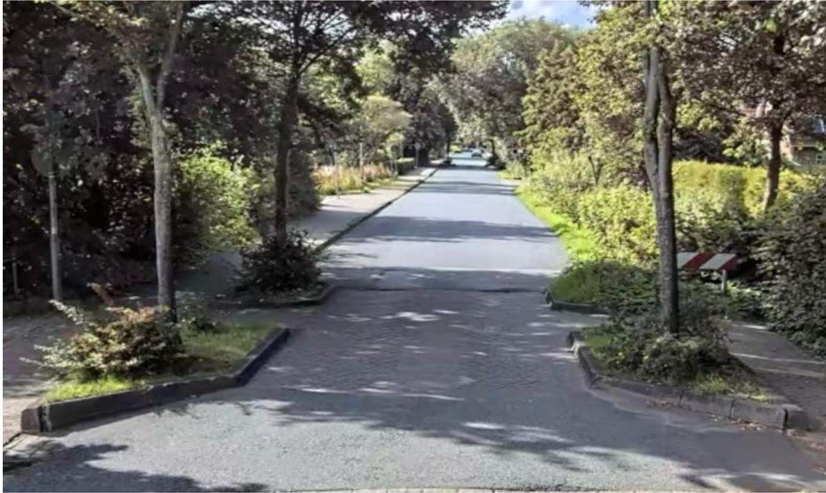
Die Aufpflasterung dieser Querungshilfe ist mittels grauer Pflastersteine als Anrampung herzustellen um die Verkehrsteilnehmer abzubremsen. Die Pflasterung der Querung ist mit roten Pflastersteinen ersichtlich abzusetzen. In den seitlichen Einengungen können Bepflanzungen durchgeführt oder Rasen angesät werden.
